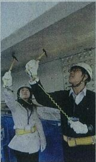
ハンマーで首都高の高架橋をたたいて異常がないかどうか調べるジュニア記者
